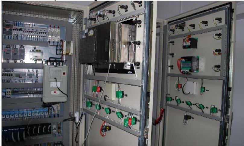
Fig. 4. . Instalația de Automatizare Grup Motor de curent continuu – Generator Sincron
